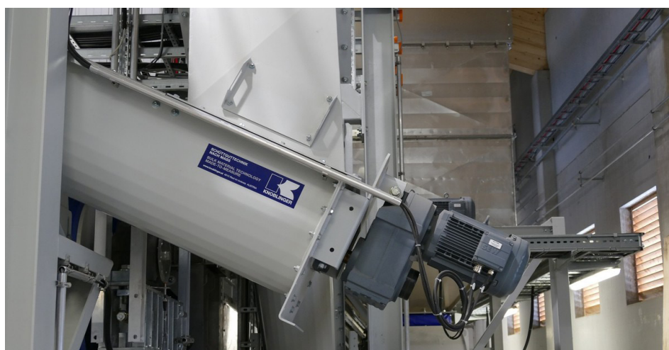
Abbildung 3: Checkmk kann auch Industrieanlagen überwachen
